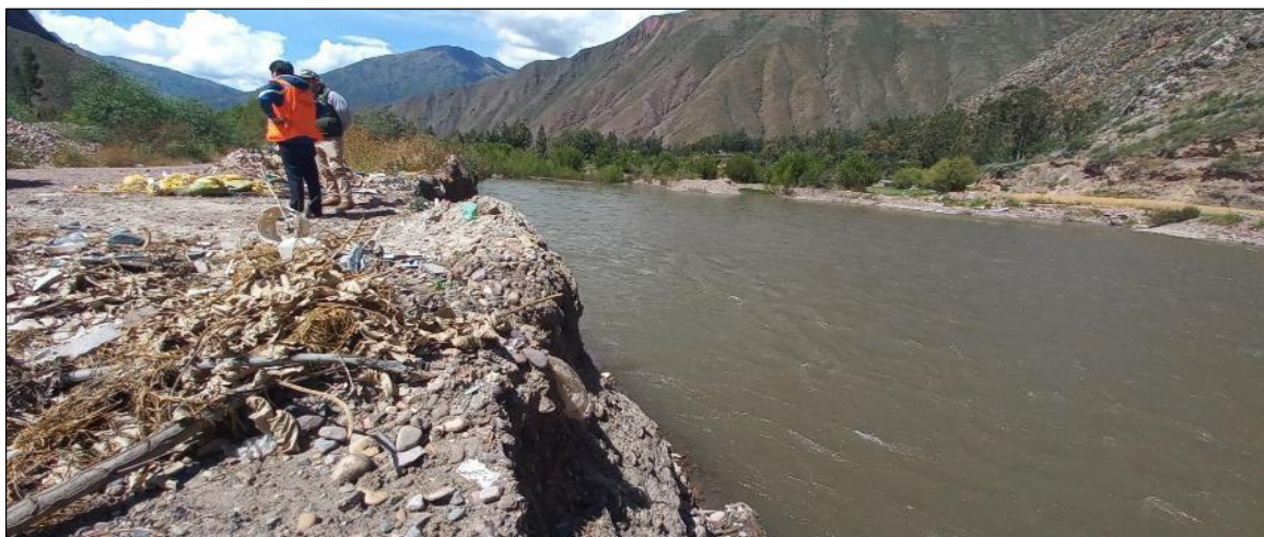
FIGURA N°01: BASE DEL TALUD DEL RIO SE OBSERVA EL SOCAVAMIENTO Y EROSION DEL MISMO EL CUAL DEBILITA Y PODRIA AFECTAR VIVIENDAS Y AREAS DE CULTIVO.
