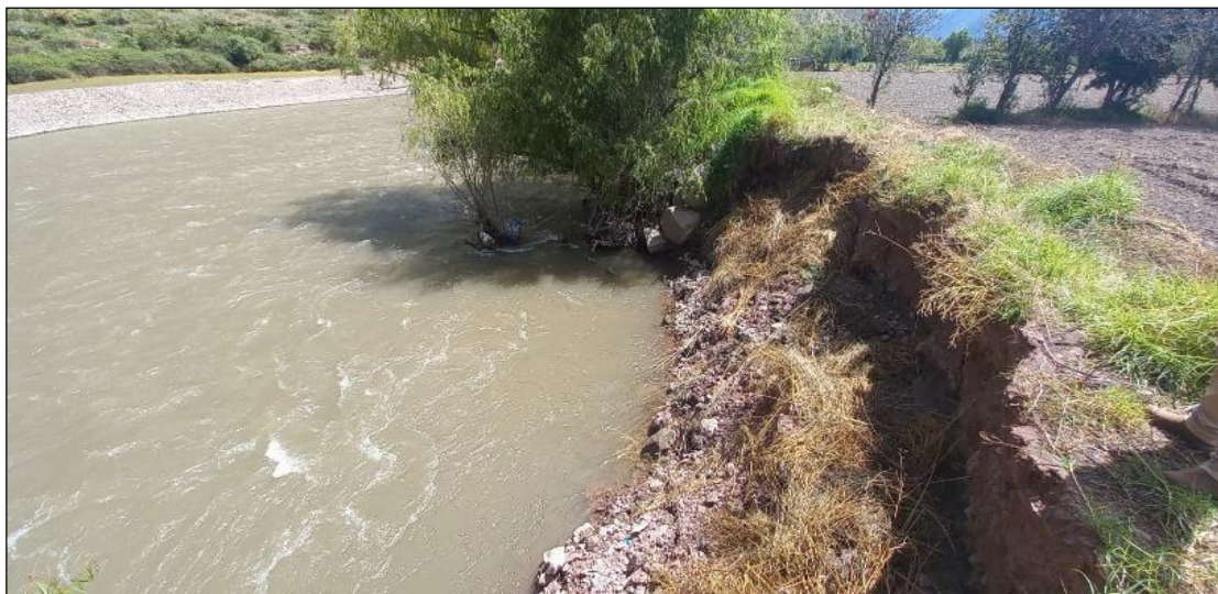
FIGURA N°02: BASE DEL TALUD DEL RIO SE OBSERVA EL SOCAVAMIENTO Y EROSION DEL MISMO EL CUAL DEBILITA Y PODRIA AFECTAR LOS TALUDES DEL CAUCE DEL RIO VILCANOTA.
